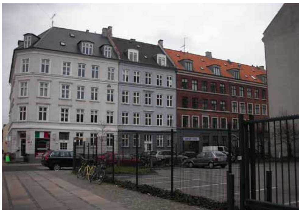
Facader i Fanøgade over for lokalplanområdet.
