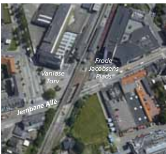
Luftfoto af jernbaneviadugten over Jernbane Allé.
