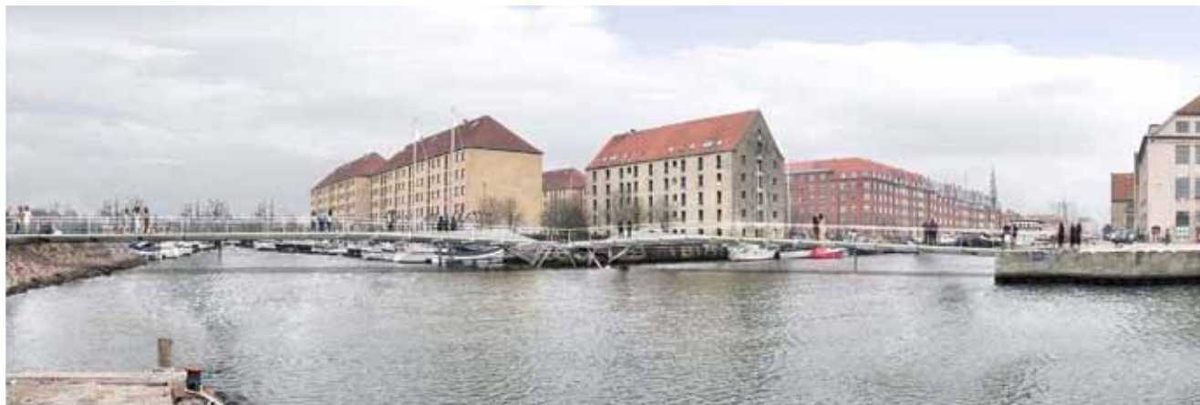
Kanalbro over Trangraven og Christianshavns Kanal.
